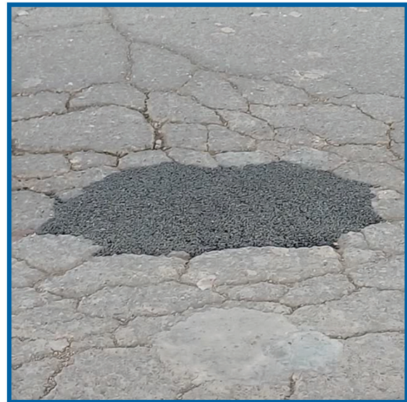
◀◀ شکل ۲) ترمیم روسازی آسفالتی یک ساعت بعد از اجرا آسفالت سرد
