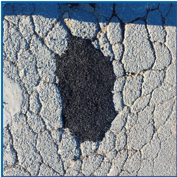
◀◀ شکل ۳) ترمیم روسازی آسفالتی بلافاصله بعد از اجرا آسفالت سرد
