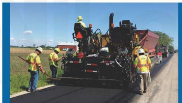
شکل ۳) اجرای روکش آسفالتی
