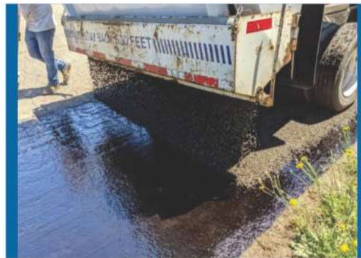
شکل ۲) اجرای چیپ سیل
