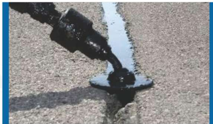
شکل ۴) عملیات درزگیری ترک های آسفالتی
